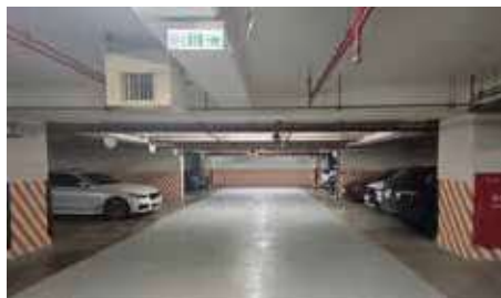
完成 B1 停車場車道鋪設 Epoxy 工程
