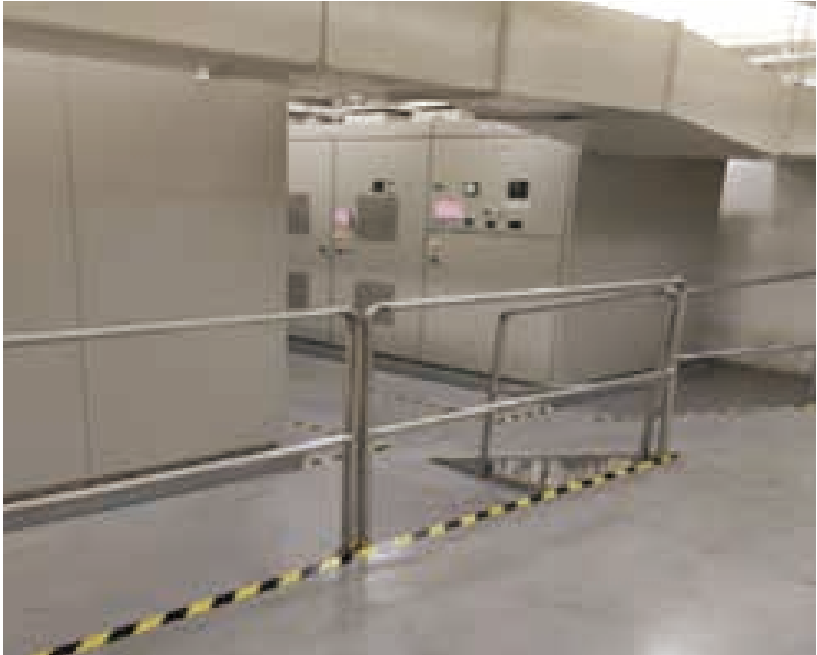
▼ 改善方案一：已裝設安全護欄
