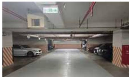
完成 B1 停車場車道鋪設 Epoxy 工程
