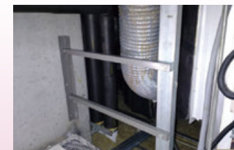
安裝防護圍欄
