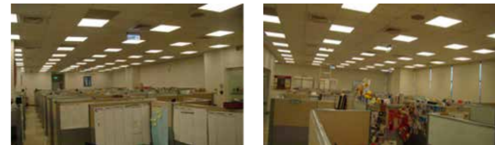
▲辦公室及走道區更換 LED 照明燈具
