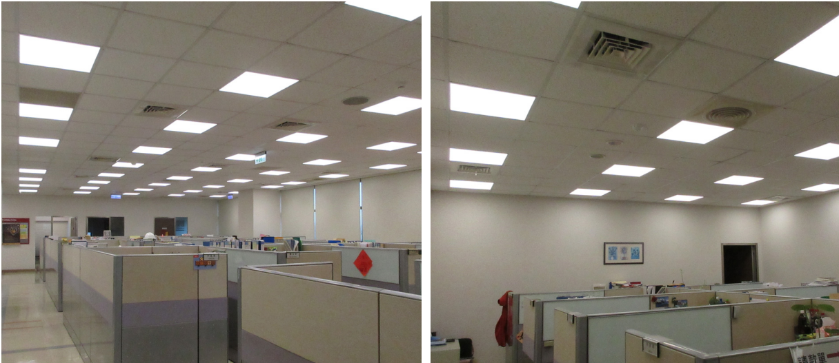
▲ 辦公室及走道區更換 LED 照明燈具
